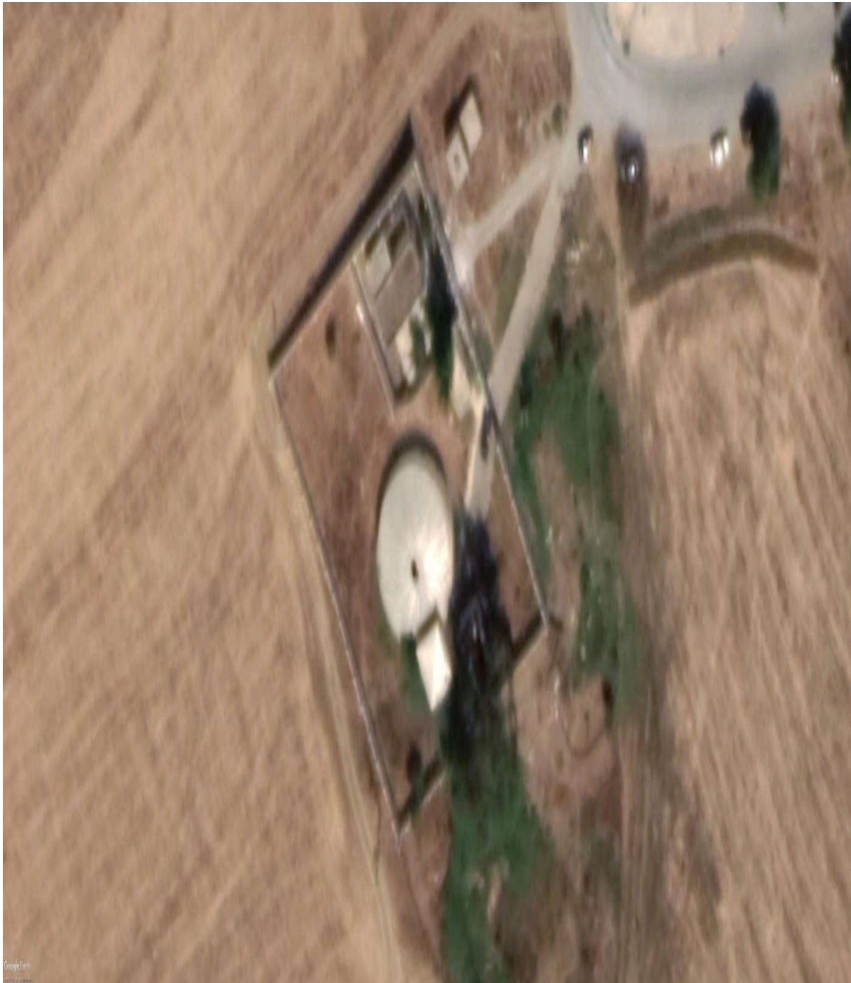
Figure 6 : Installation de réservoir Hôpital (GOOGLE MAPS 2021).
